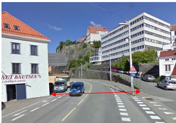
Figur 16: Det trangeste punktet på strekningen er forbi Knut Knutsen-boden i Skuteviken (Skuteviksboder 10). Her er det kun 12,4 meter mellom hjørnet på boden og enden av muren under Nordre Skuteviksveien.
