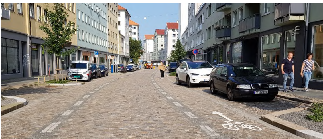
Figur 32: Strandgaten er nylig rustet opp med nytt gatedekke og sykkel felt. Her er fartsgrensen satt til 30 km/t, og ÅDT er under 4000, et trafikkbilde sammenlignbart med Sjøgaten. Det er lagt opp til omfattende langsgående parkering, samt varelevering i gaten.
